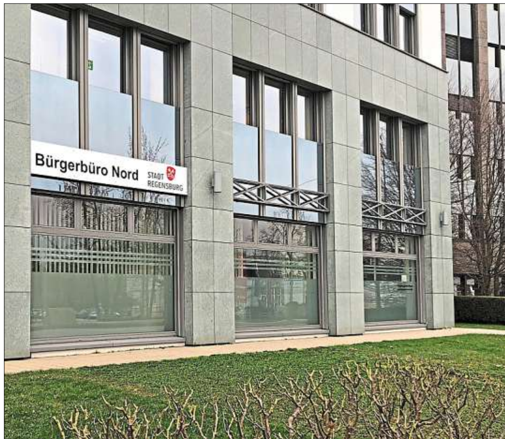
An der Schauseite zur vielbefahrenen Donaustauerstraße ist das Bürgerbüro gut markiert. Fotos: Wendl
