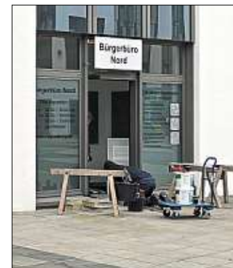
Letzte Arbeiten am Eingang
